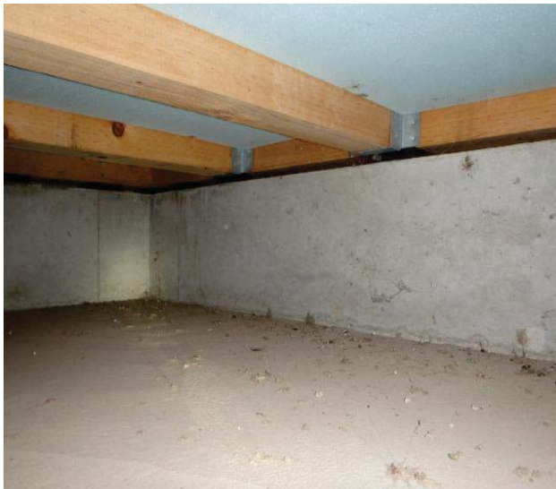
写真1. 床下状況 基礎際部
