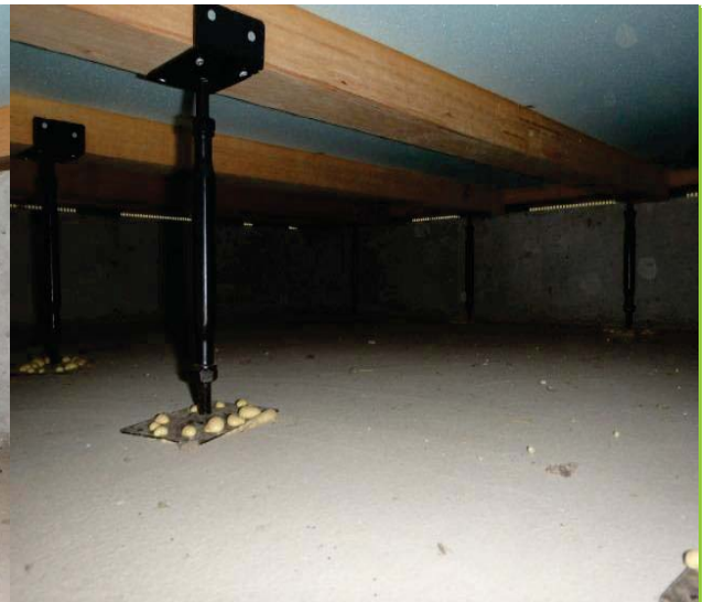
写真2. 床下状況 居住部
