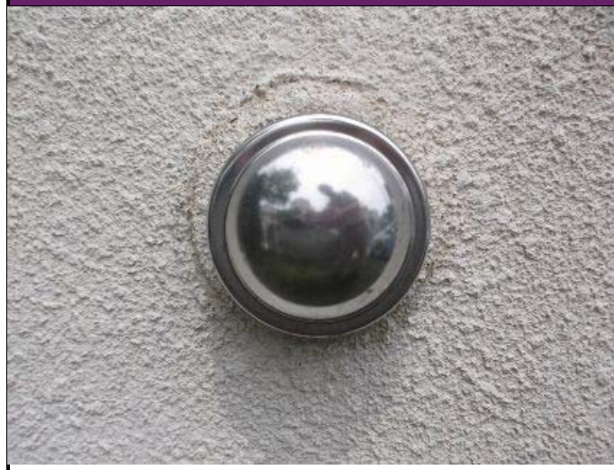
外壁貫通部(設備配管など)
