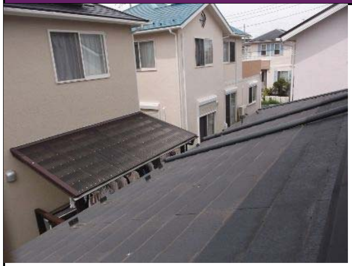
屋根(写真撮影が可能な場合)
