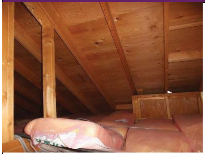
小屋裏(写真撮影が可能な場合)
